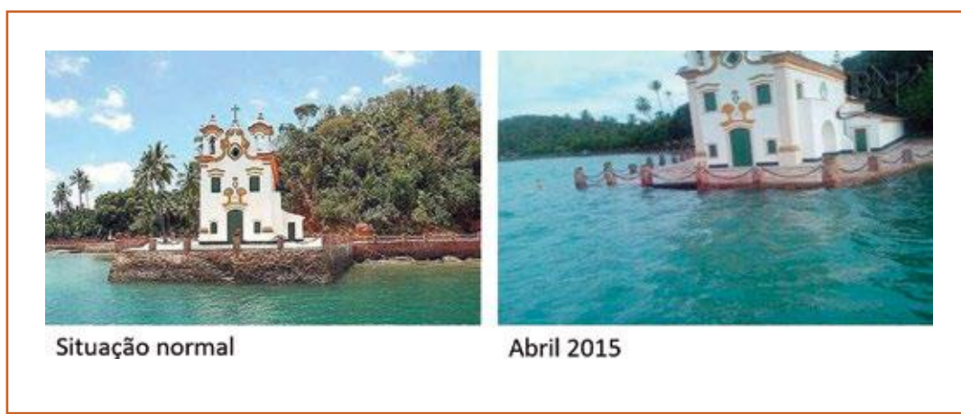
Figura 7.14 Igreja de Nossa Senhora do Loreto, na Ilha dos Frades, em Salvador. Em abril de 2015, a maré alcançou 3,30 metros de altura e quase atingiu a construção de 1617. Na época, o que salvou a construção histórica foi a construção de uma barreira pela proprietária da Fazenda Loreto.
