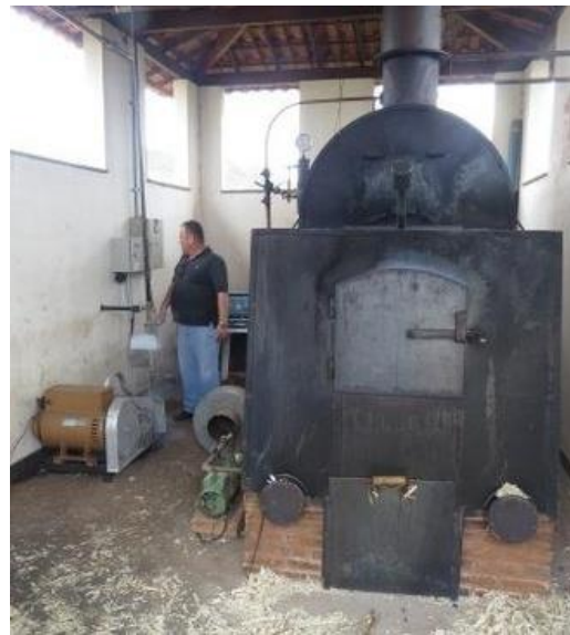
Figura 1: Caldeira, turbina e gerador AC.
