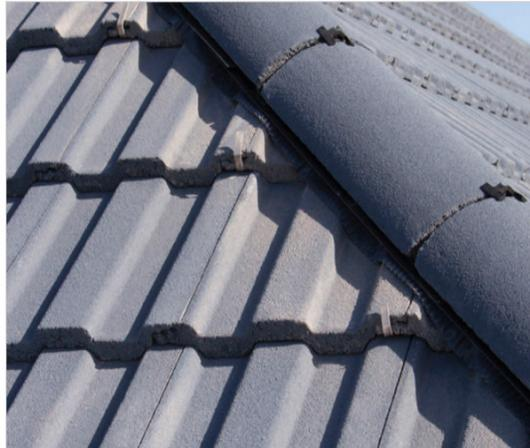
Figura 4: Telhas de Concreto
