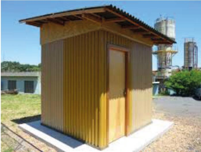
Figura 5 – Protótipo de tubos de papelão
