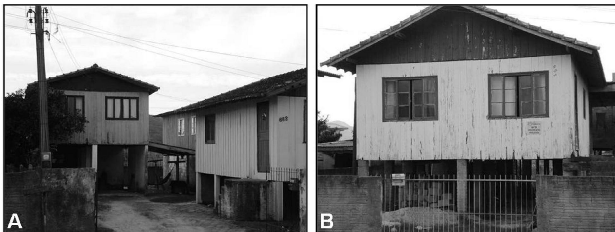
Figura 6: A e B) Casas construídas sobre pilotis para prevenir as inundações, bairro Flor de Nápoles.
