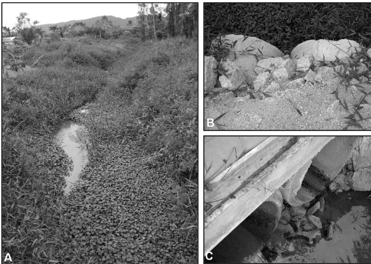
Figura 3: A) Detalhe de um dos vários canais presentes no setor de suscetibilidade muito baixa às inundações, bairro Forquilhas. B) Tipo de tubulação que foi colocada para escoar as águas que passam pelos canais. C) Maior detalhe da tubulação.
