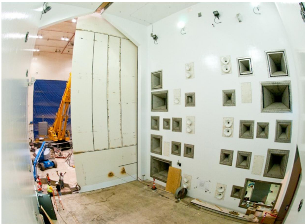
Figura 8. Instalação da porta principal na RATF
