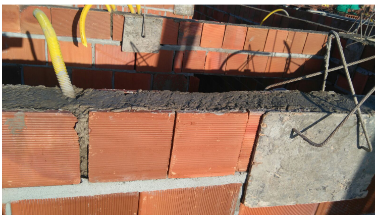
Figura 2. Cintas de amarração com bloco canaleta.
