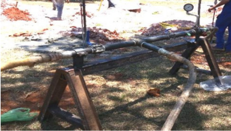
Figura 5. Sistema de bomba para injeção dos EB.
