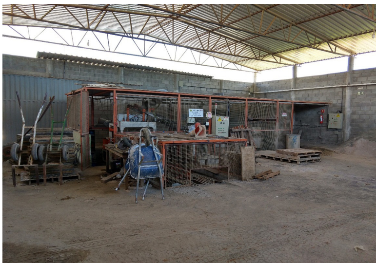
Figura 3- Revestimento de segurança da prensa hidráulica com telas de aço.
