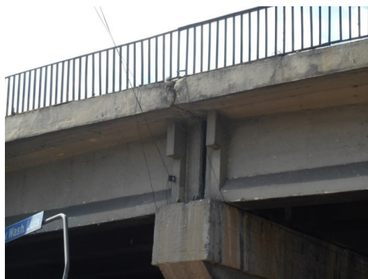
Figura 14 - Aparelho de apoio não visualizado (Autor)
