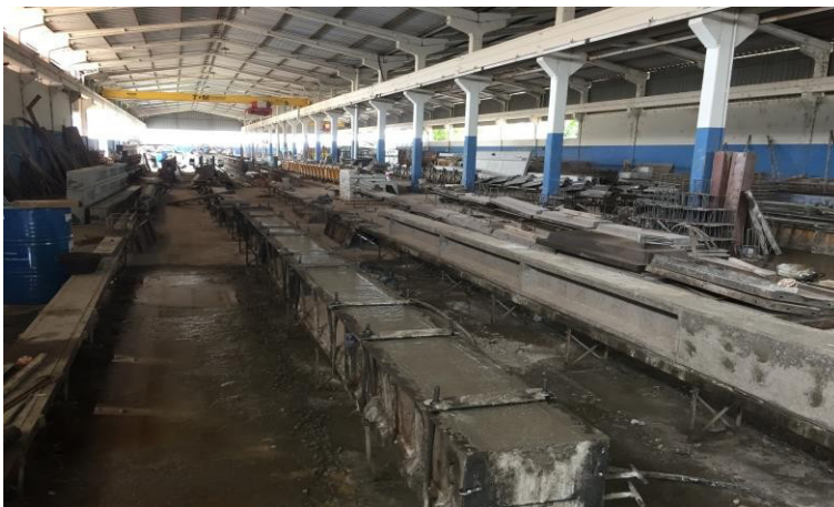
Foto 2 – Formas e Concretagem dos pré-moldados
