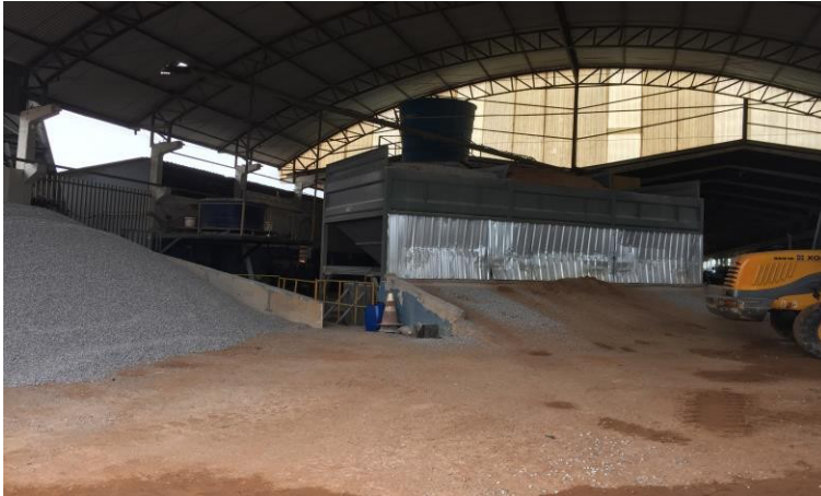
Foto 1 – Usina de fabricação de concreto usinado
