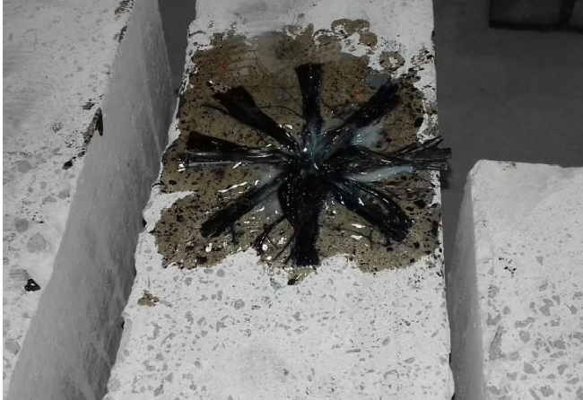
Figura 2 - Sistema de ancoragem aplicado
