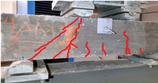
Figura 30 – V04–C fissuras após o ensaio.
