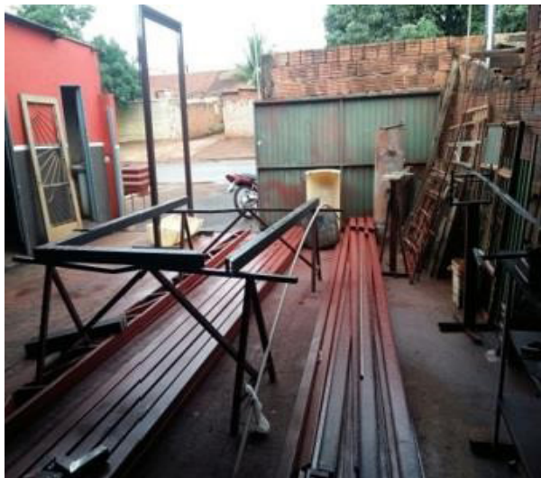
Figura 4 - Armazenamento Inadequado das Vigas Metálicas
