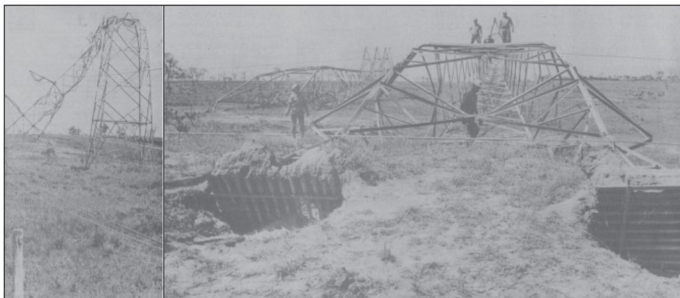
Figura 2 – Dano (a) e Queda (b) de Torres da Linha Jupuí Campo Grande – Episódio ACL (15.10.1992)
