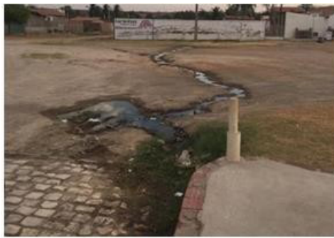
Figura 3 – Área com esgoto a céu aberto em ruas não calçadas no bairro Leandro Bezerra
