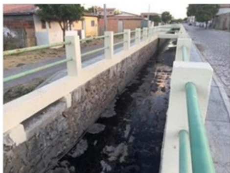
Figura 5 – Canal de Esgoto (Centro)
