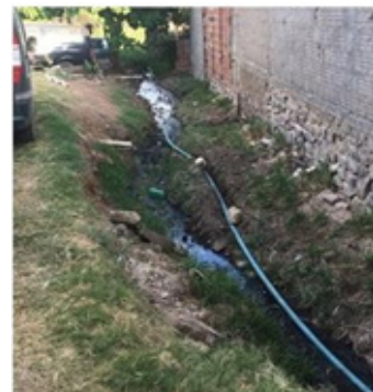
Figura 6 – Corpo d'água direcionado para o canal principal (Bairro Centro)
