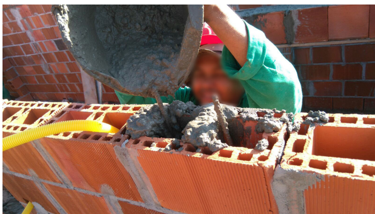
Figura 1. Preenchimento com graute.
