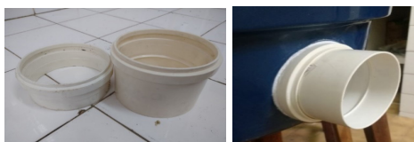
Figura 7 – Luvas de PVC de 100 mm cortadas para conexão do tubo de alimentação à caixa d'água (esquerda) e detalhe da vedação com silicone (direita).
