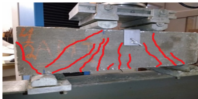
Figura 29 – V04–B fissuras após o ensaio.
