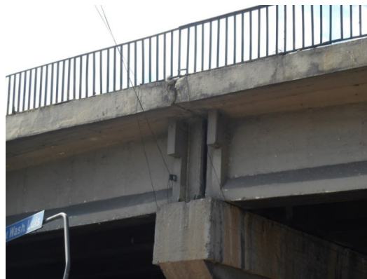
Figura 14 - Aparelho de apoio não visualizado (Autor)
