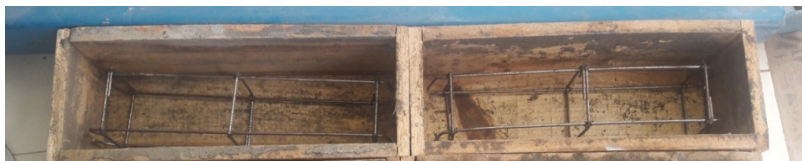
Figura 3 - Armaduras e fôrmas utilizadas (Autor)
