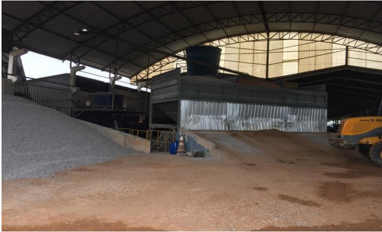
Foto 1 – Usina de fabricação de concreto usinado
