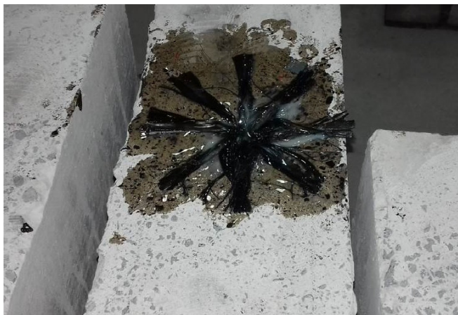
Figura 2 - Sistema de ancoragem aplicado
