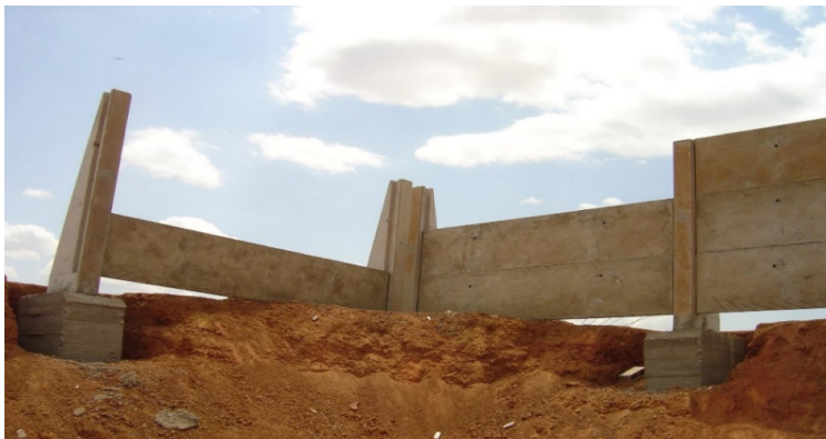
Figura 5 – Montagem de painéis pré moldados de silo horizontal.
